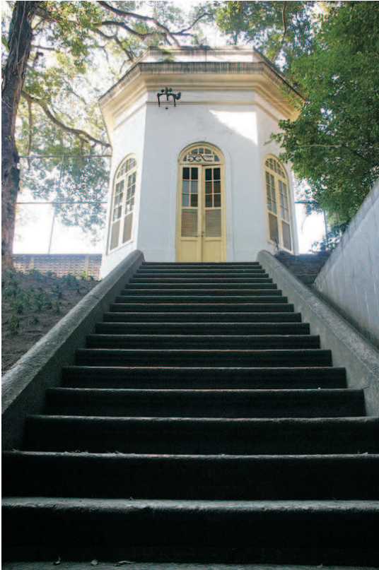
Casa de manobras. Julho/2006
