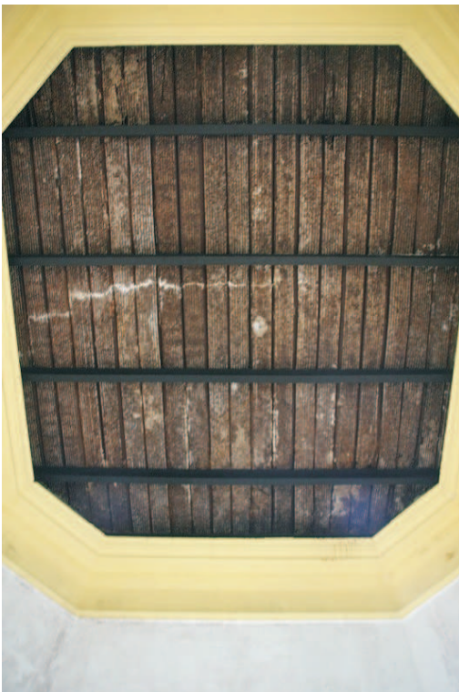
Forro da casa de manobras. Julho/2006
