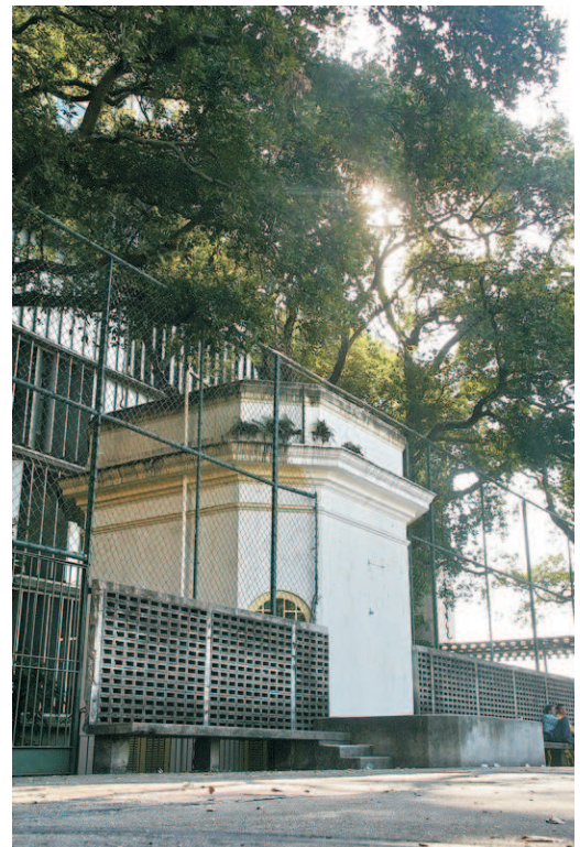
Casa de manobras. Julho/2006
