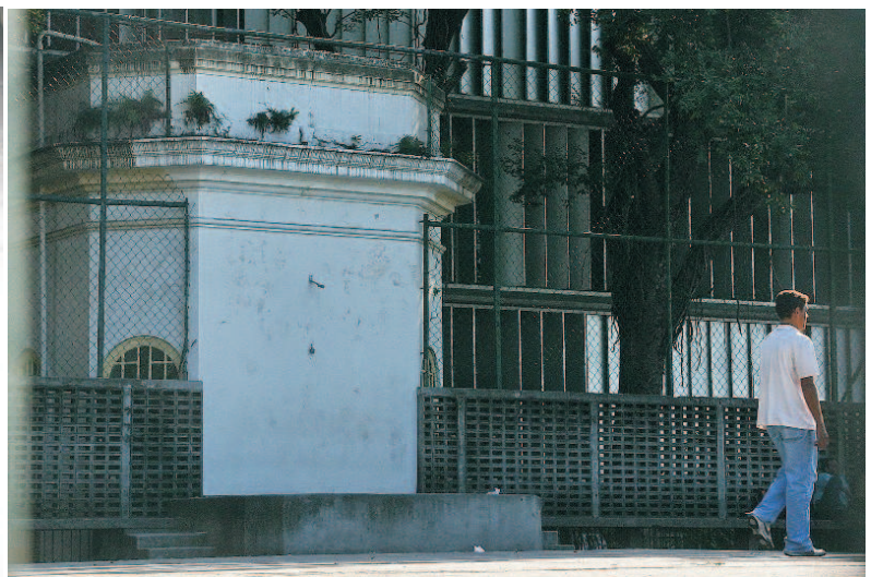
Casa de manobras. Julho/2006
