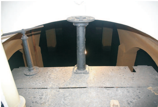
Visita ao reservatório . Julho/2006
