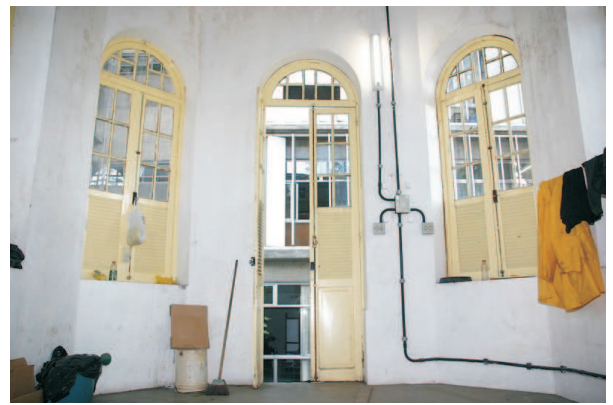
Interior da casa de manobras. Julho/2006
