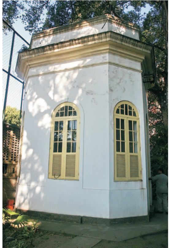
Casa de manobras. Julho/2006
