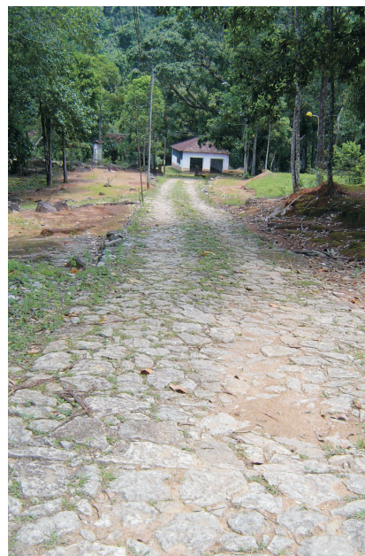
Calçamento em «pé-de-moleque» na área do Reservatório. Foto Roberto da Luz 2006.
