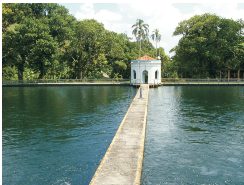
Reservatório. Foto: Roberto Anderson 2012
