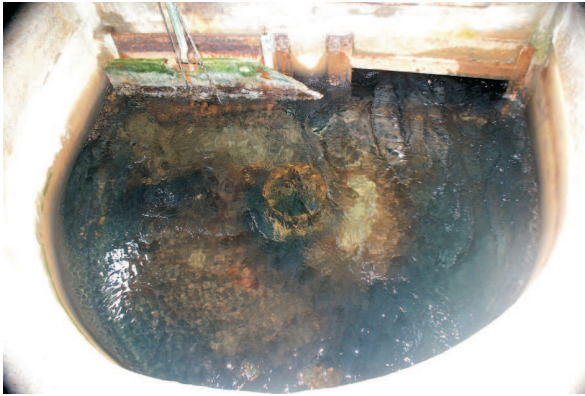
Entrada de água. 08/2006.
