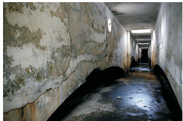
Infiltrações nas paredes do reservatório. 08/2006.
