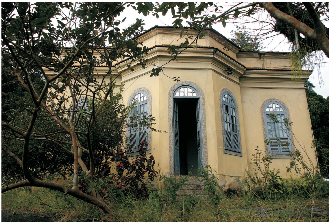
Reservatório do França - residência do encarregado. 08/2006.
