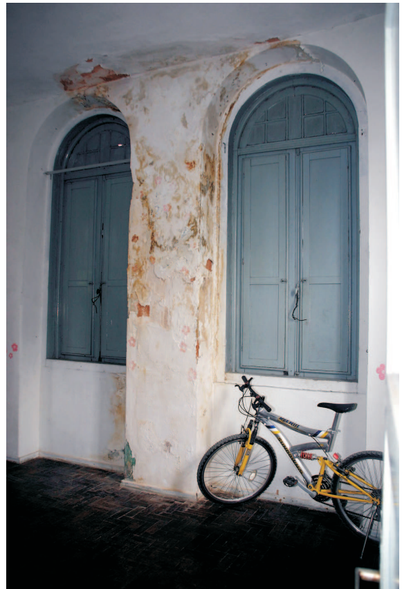
Infiltrações na parede da residência. 08/2006.
