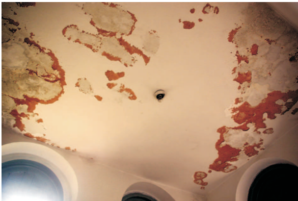
Infiltrações no teto da residência. 08/2006.
