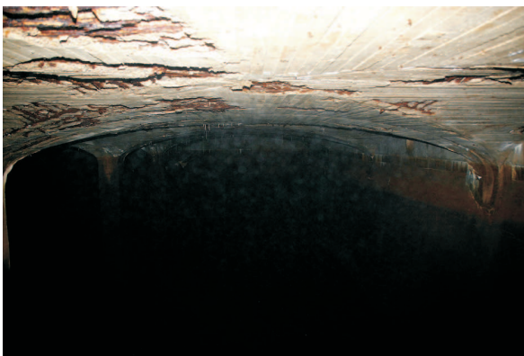
Teto do reservatório. 08/2006.
