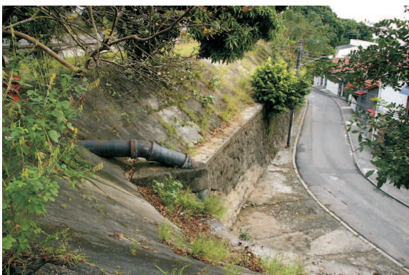
Muro de pedra e talude. 08/2006.
