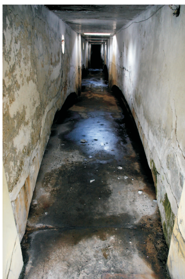
Interior do reservatório. 08/2006.
