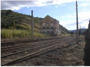
vista da linha férrea
