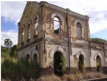
vista da linha férrea
