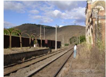
vista da linha férrea
