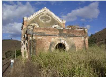
vista da linha férrea
