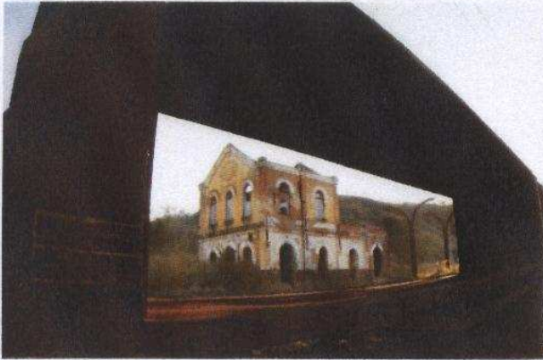
Vista da linha férrea
