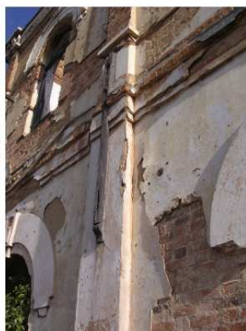
resquícios da estrutura de sustentação da cobertura da plataforma
