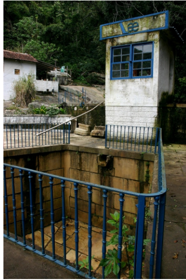
Infiltrações no posto de tratamento. 08/2006.
