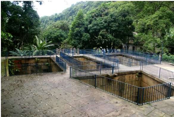
Caixas do Carioca e Decantador. 08/2006.
