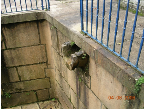
Detalhe da Caixa D'Água. 08/2006
