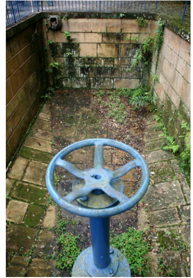
Interior das caixas d'água. 08/2006.
