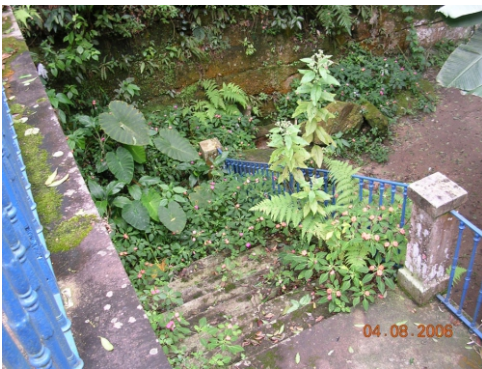
Mato na escada de acesso. 08/2006.
