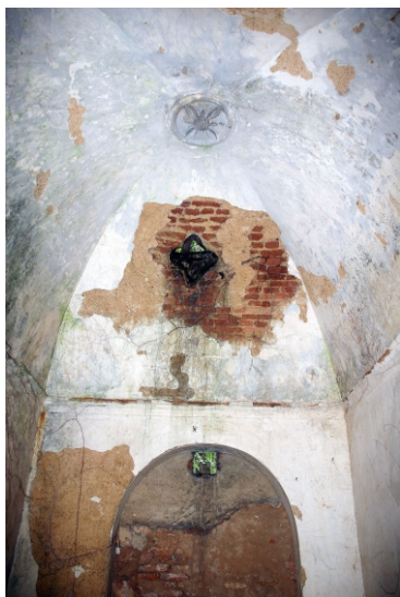
Interior da Caixa da Mãe D'água. 08/2006.
