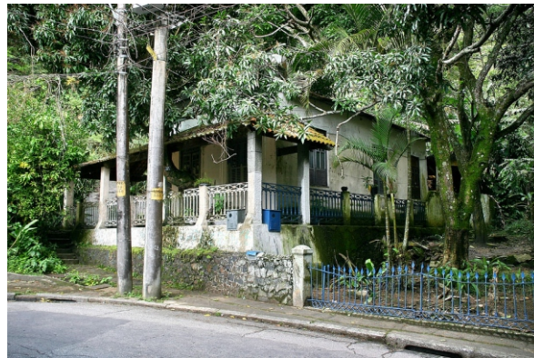
Casa do encarregado das Caixas. 08/2006.
