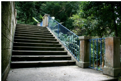
Escada de acesso aos reservatórios
