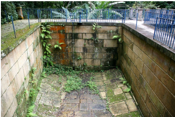
Interior da caixa d'água. 08/2006.
