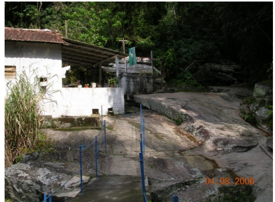
Acréscimo de telhado na casa do encarregado do cloro. 08/2006.
