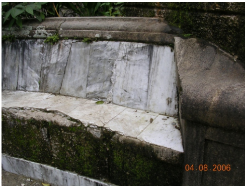
Revestimento do banco danificado. 08/2006.
