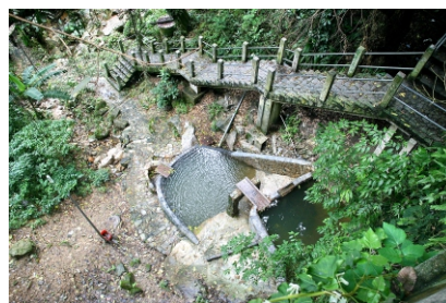
Tanque abaixo da Rua Almt. Alexandrino
