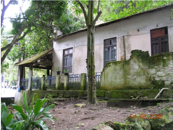
Acréscimo de telhado na casa do encarregado. 08/2006.
