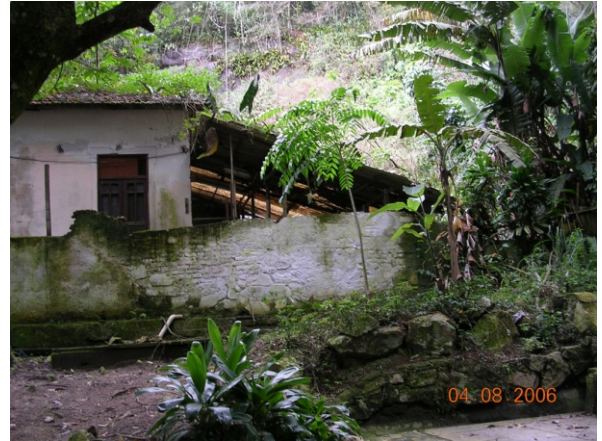
Acréscimo de telhado na casa do encarregado. 08/2006.
