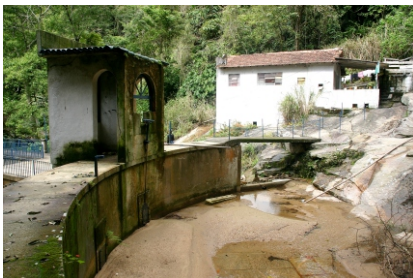
Barragem e casa do encarregado do cloro
