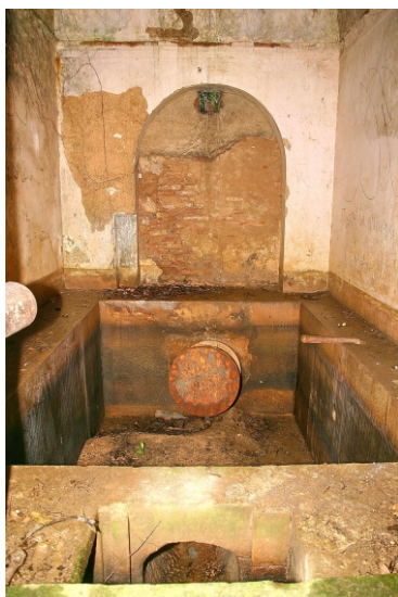
Interior da Caixa da Mãe D'água. 08/2006.
