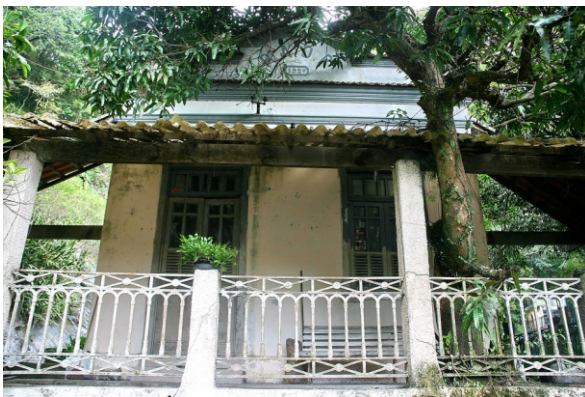
Acréscimo de telhado na casa do encarregado. 08/2006.
