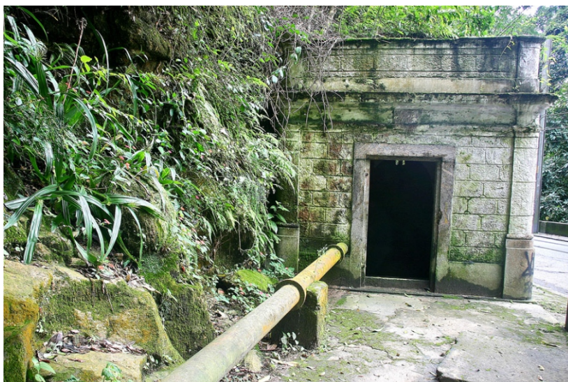
Entrada da Caixa da Mãe D'água. 08/2006.
