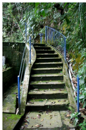
Escada de acesso à barragem
