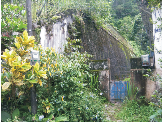
Muro do Açude. 2013.
