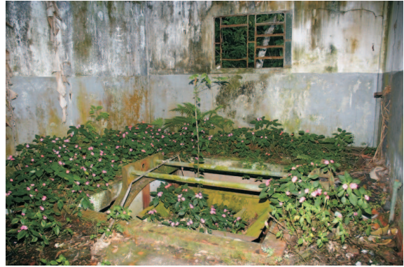
Interior do Posto de Tratamento.
