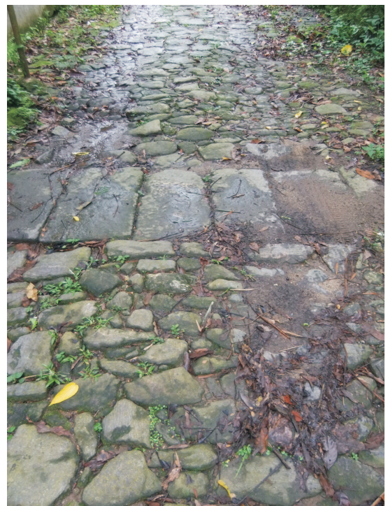
Detalhe da pavimentação do caminho. 07/2013.
