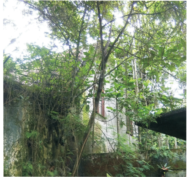
Casa ao lado da Caixa D'Água - 2013
