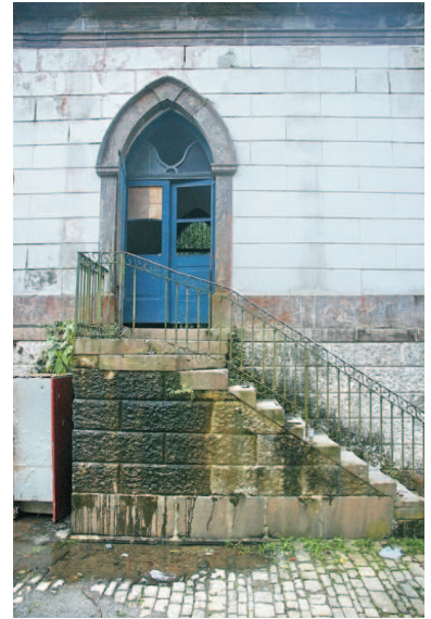
Acesso na fachada dos fundos. 08/2006.
