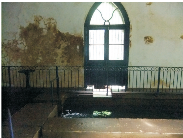
Interior da Caixa D'Água. 07/2013.
