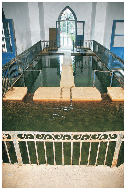
Interior da Caixa Velha, frente. 08/2006.
