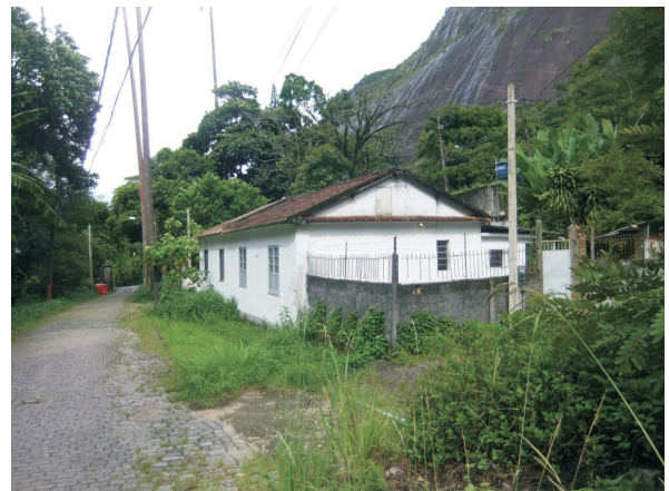
Casa de funcionário no terreno do Reservatório 07/2013.
