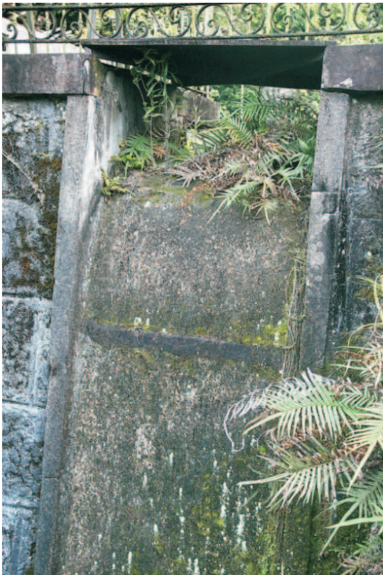
Detalhe do ladrão. 08/2006.
