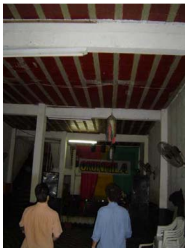
Estrutura da laje alterada e circulação vertical inadequada
