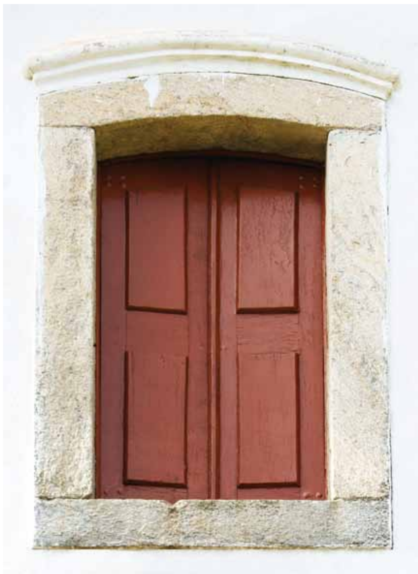
Janela Elemento Arquitetônico Capela Santana Rio Bonito Madeira pintada e metal H 198 | L 105 Século XVIII/XIX
