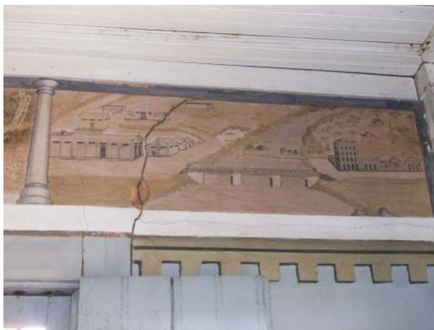
Detalhe interno da casa do Sr. Lindolpho.
