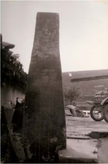
Chaminé do engenho de açúcar. Fazenda Vargem Alegre - Varre-Sai.
