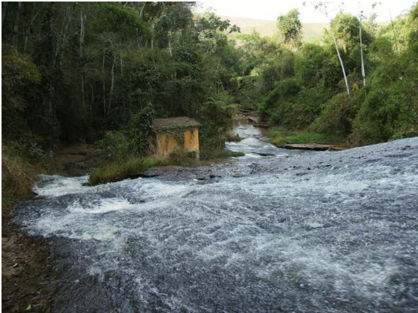
Cachoeira do Tatão Randolpho. Detalhe da casa de força. 2011.
