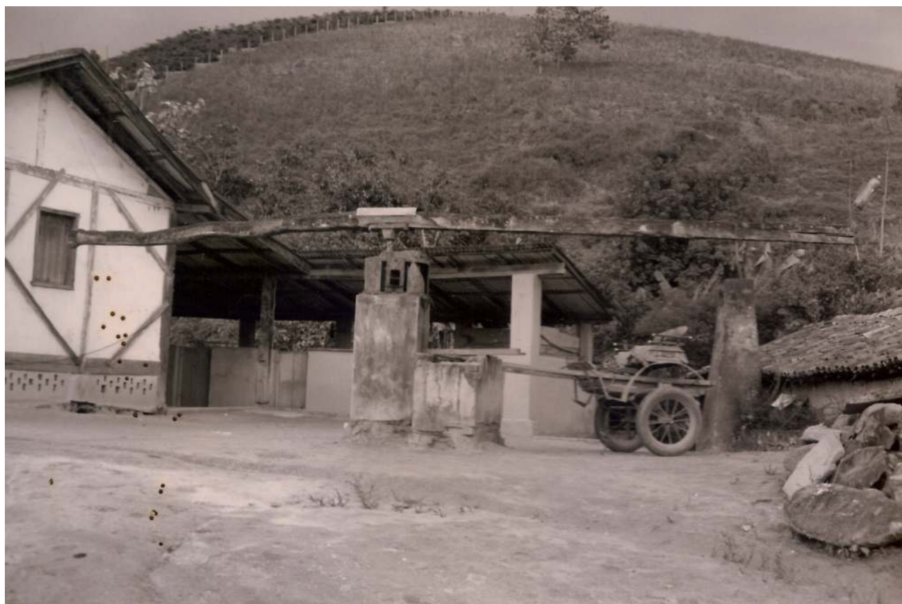
Engenho de cana movido por tração animal. Fazenda Vargem Alegre - Varre-Sai.
