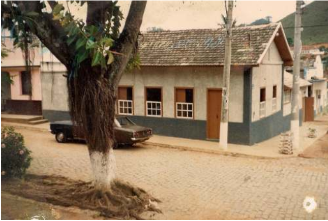
Residência do Sr. Bento Machado Vieira.
