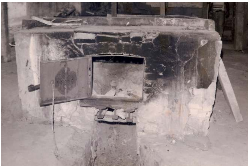
Detalhe da fornalha da Fazenda dos Pirozzi.
