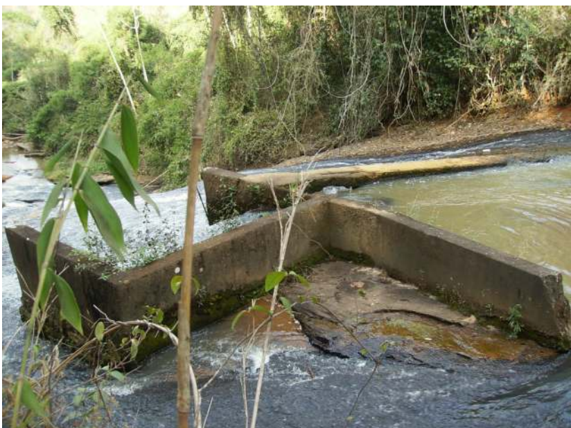
Cachoeira do Tatão Randolpho. Detalhe da mureta de represamento. 2011.
