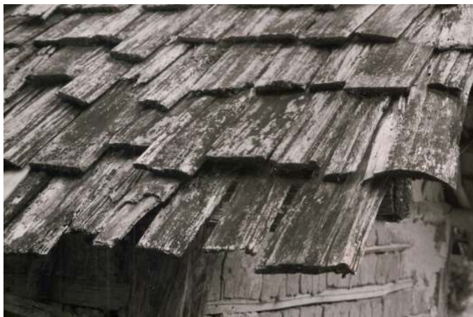
Detalhe de telhado coberto por escândulas, popularmente conhecidas como taboinhas.
