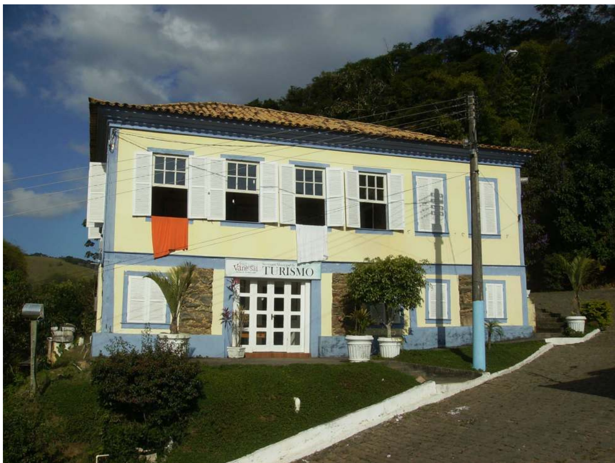
Fachada do Centro Cultural Sebastião Oliveira Vargas.
