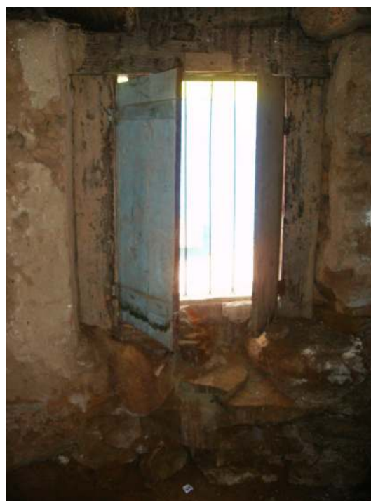
f26 - Detalhe da janela do porão.
