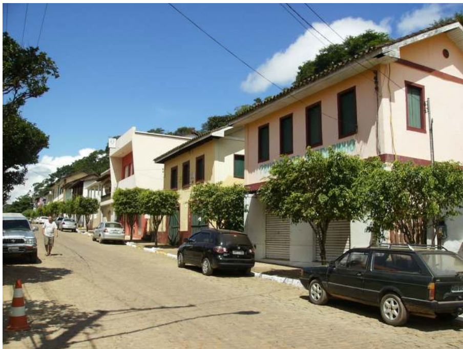
f05 - Detalhe do conjunto da parte central da Av. Felicíssimo de Faria Salgado.
