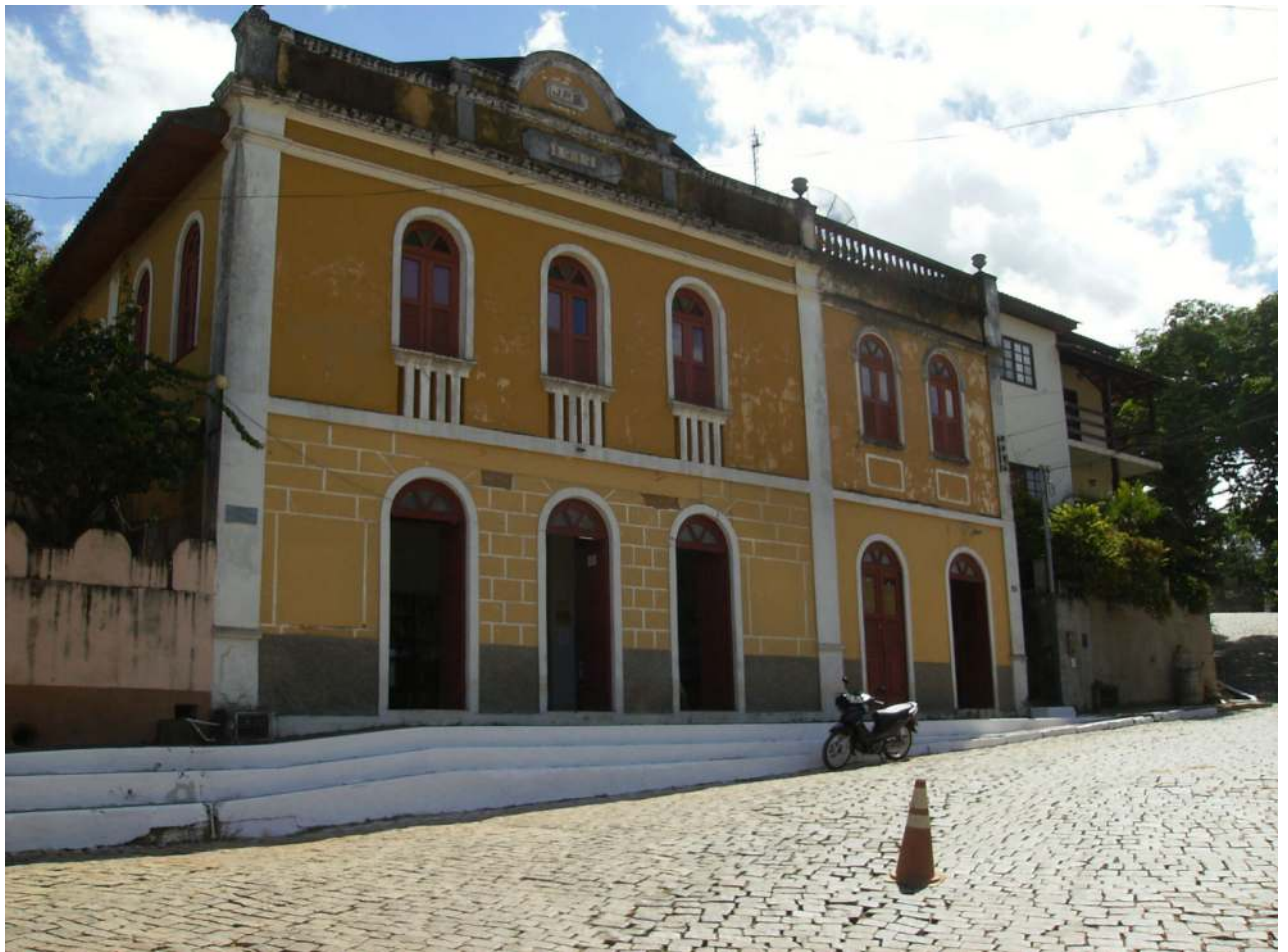
Fachada da Biblioteca Municipal.
