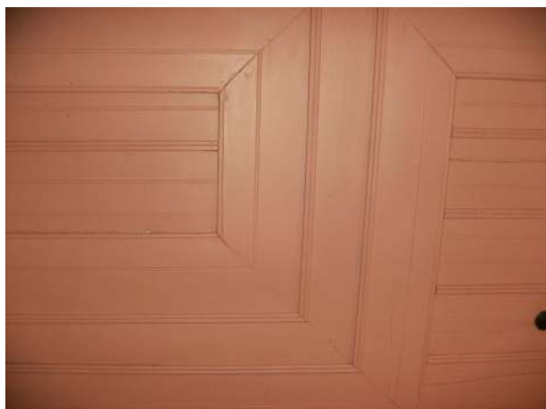
f57 - Detalhe da forração interna.
