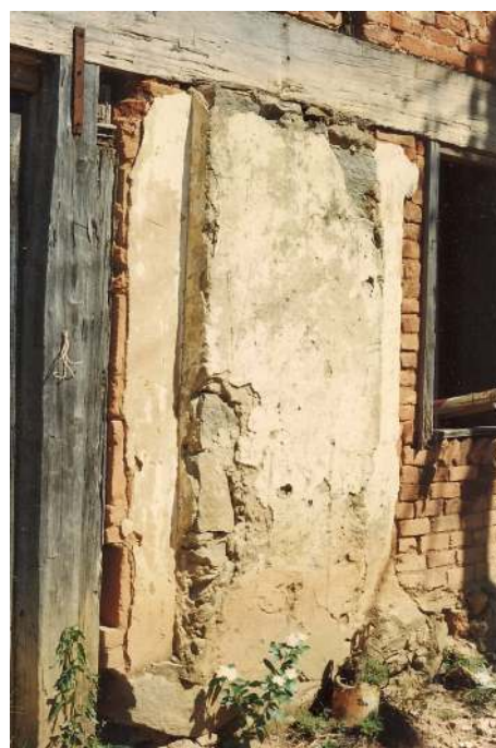
f54 - Detalhe do porão visto do pátio interno.
