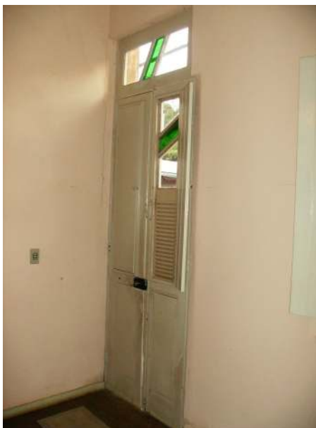
f12 - Porta principal vista de dentro.
