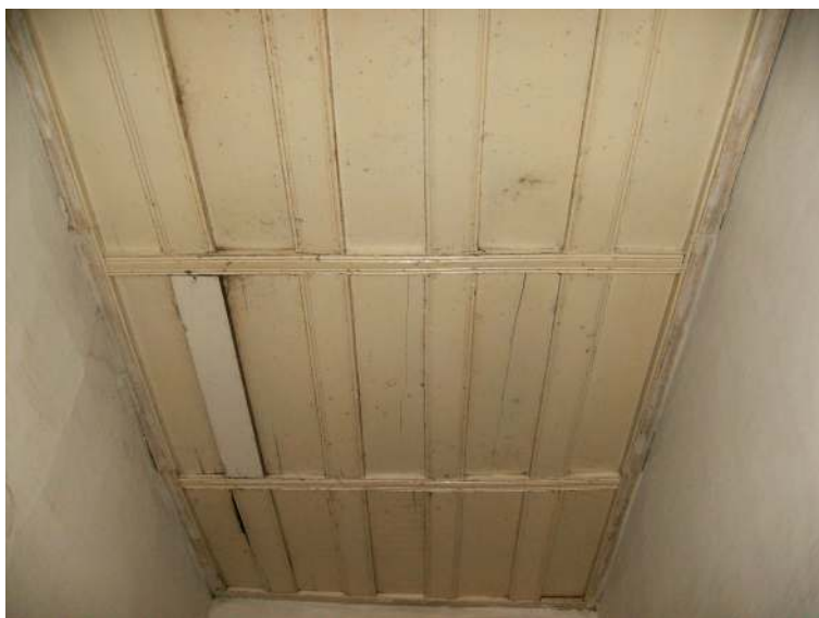
f50 - Detalhe do forro do tipo saia e camisa empregado no corredor.
