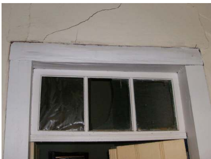
f25 - Detalhe da bandeira de porta interna.
