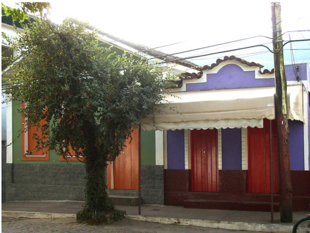
Fachada do Bar do Sapato
