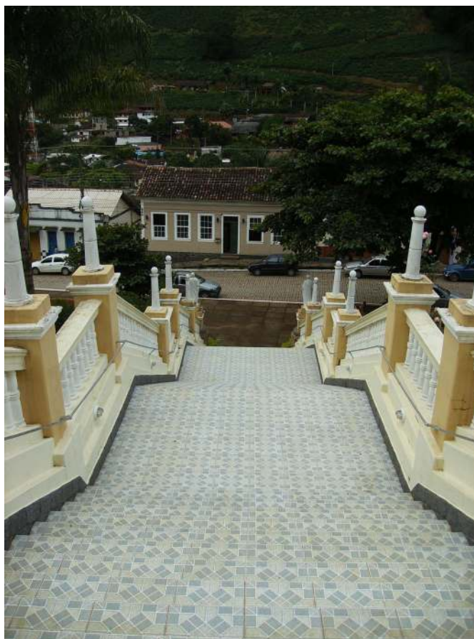
f55 - Detalhe da escadaria.
