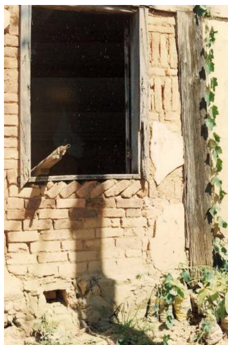
f61 - Detalhe da parede e janela do porão.
