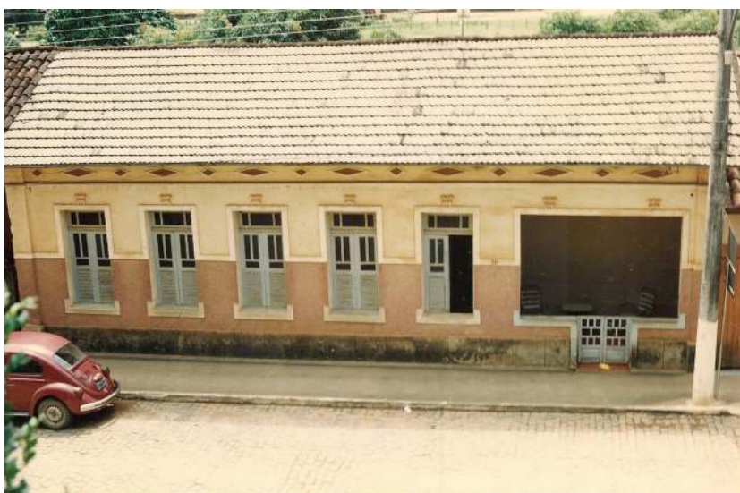
f29 - Aspecto da residência antes da construção da garagem.
