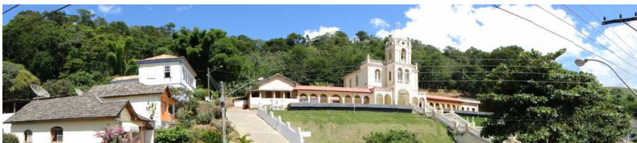
Vista do conjunto da Rua Túlio Righetti.
