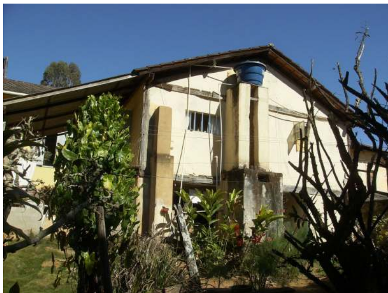
f28 - Detalhe dos fundos da construção.
