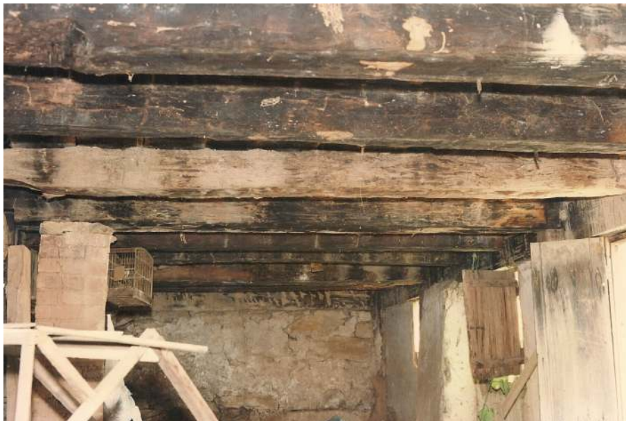
f60 - Detalhe do barroteamento do porão.
