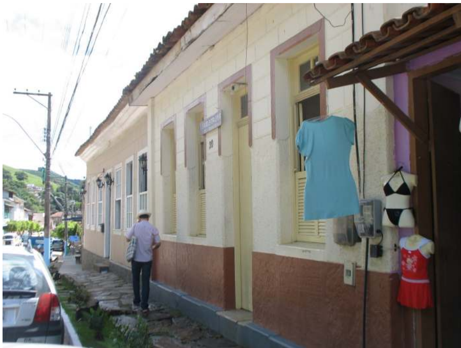
f13 - Detalhe da calçada do tipo pé de moleque.
