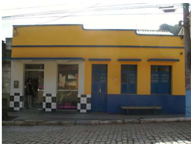
f04 - Fachada principal.
