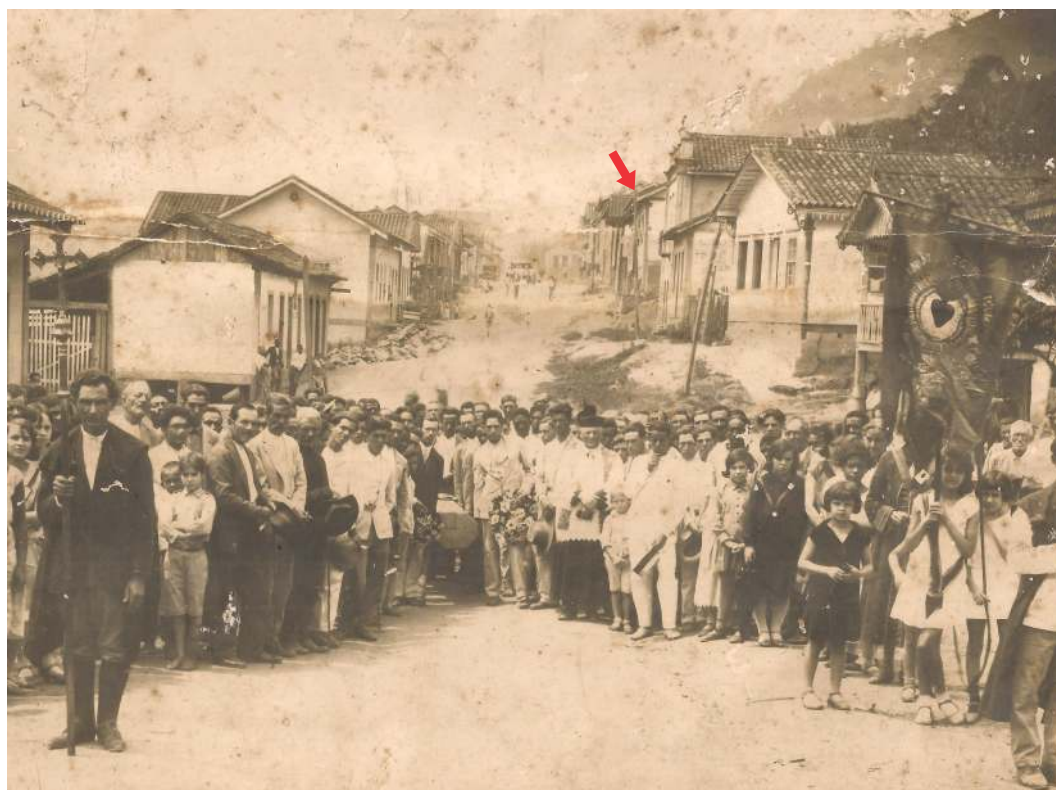
f06 - Aspecto da Av. Felicíssimo de Faria Salgado na década de 20.
