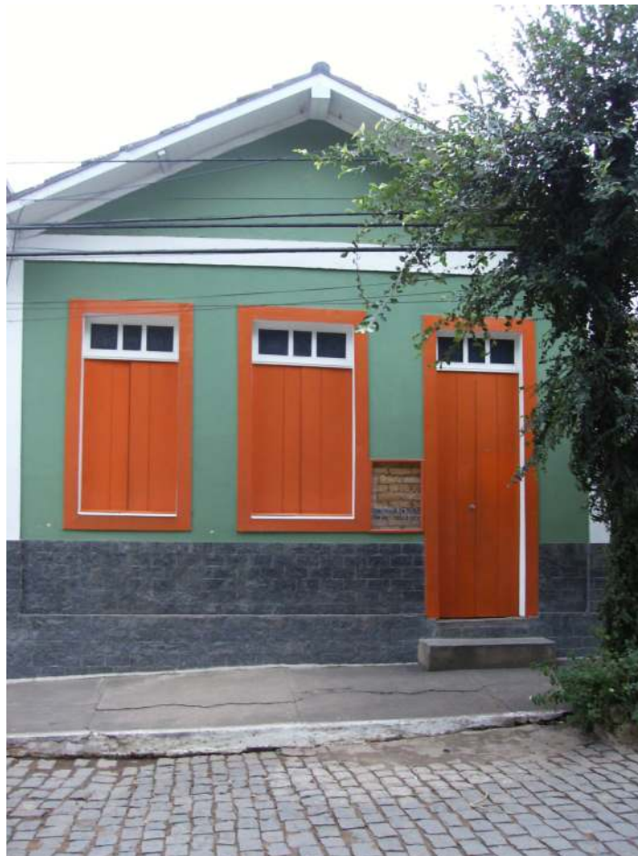
Fachada da Casa da D. Hilma
