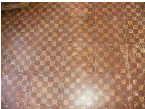
f23 - Modelo de ladrilho hidráulico utilizado no revestimento do segundo pavimento.
