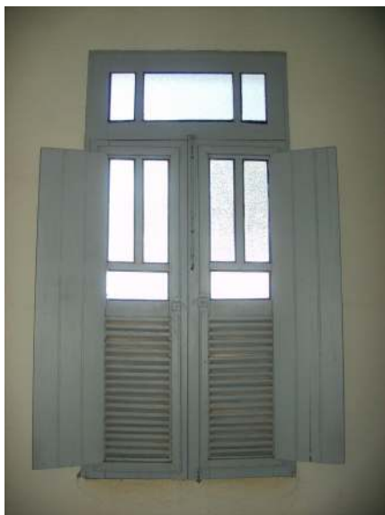
f27 - Detalhe interno da Janela.
