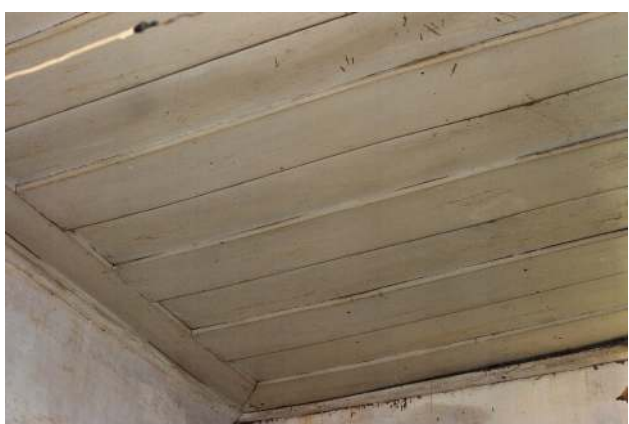
f57 - Detalhe da forração interna do tipo saia e camisa.
