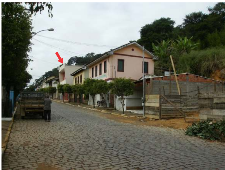
f36 - Conjunto da Avenida Felicidade de Faria Salgado.
