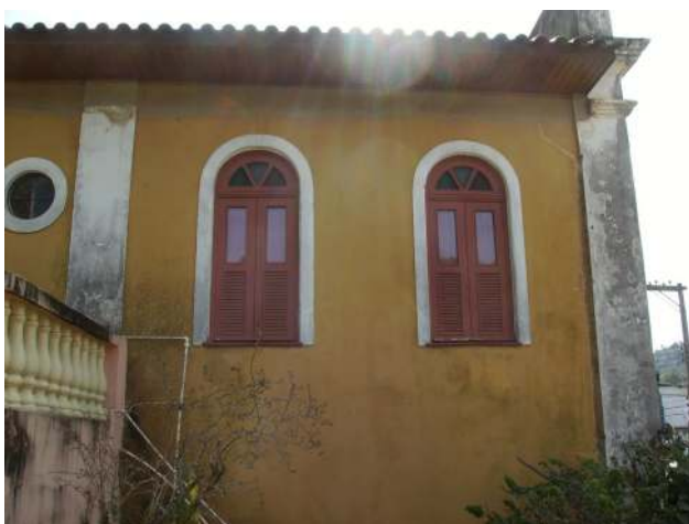
f54 - Detalhe da fachada lateral esquerda.
