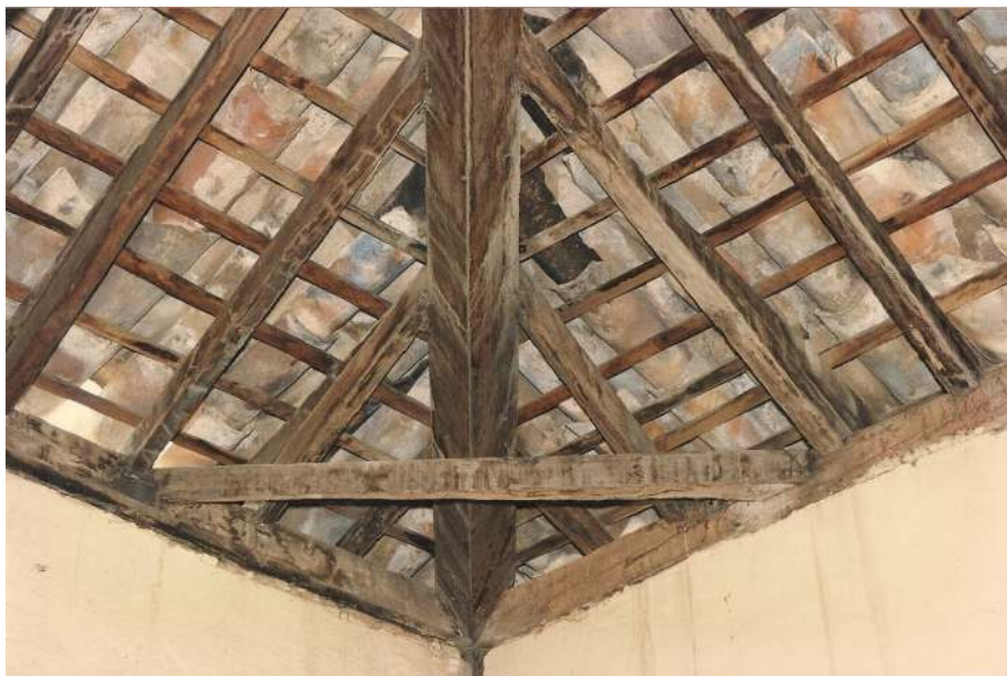
f62 - Detalhe do telhado.
