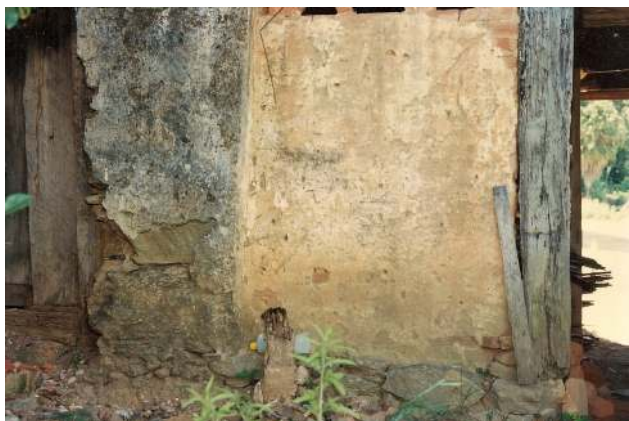
f55 - Detalhe das sapatas de pedra de mão revestidas com argamassa.
