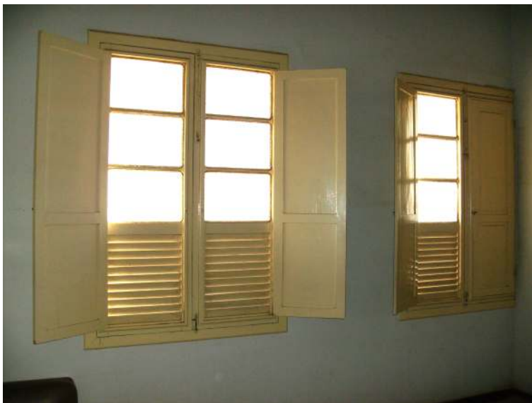
f16 - Aspecto interno das janelas da fachada principal.
