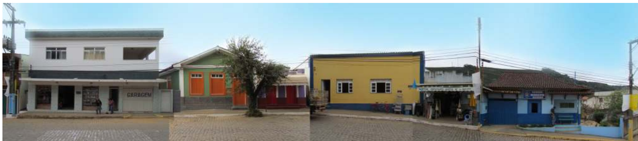
Vista do conjunto do Largo Santa Filomena.
