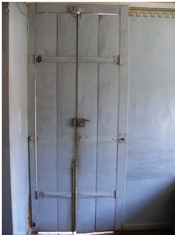
f46 - Detalhe interno da porta da entrada principal.
