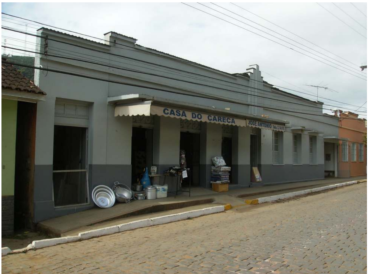
Fachada da Casa do Careca.
