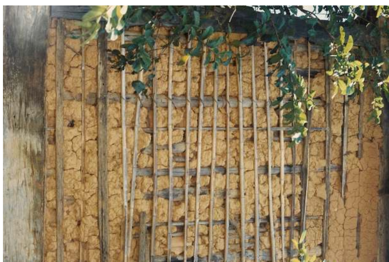
f59 - Detalhe de parede de pau a pique.
