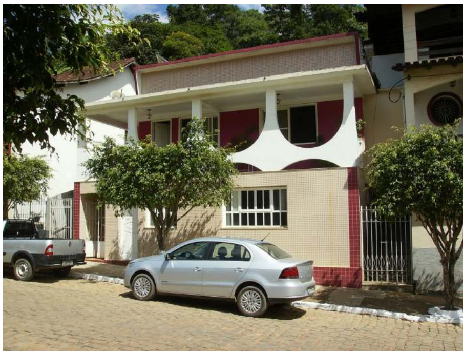
f05 - Detalhe dos pilares.
